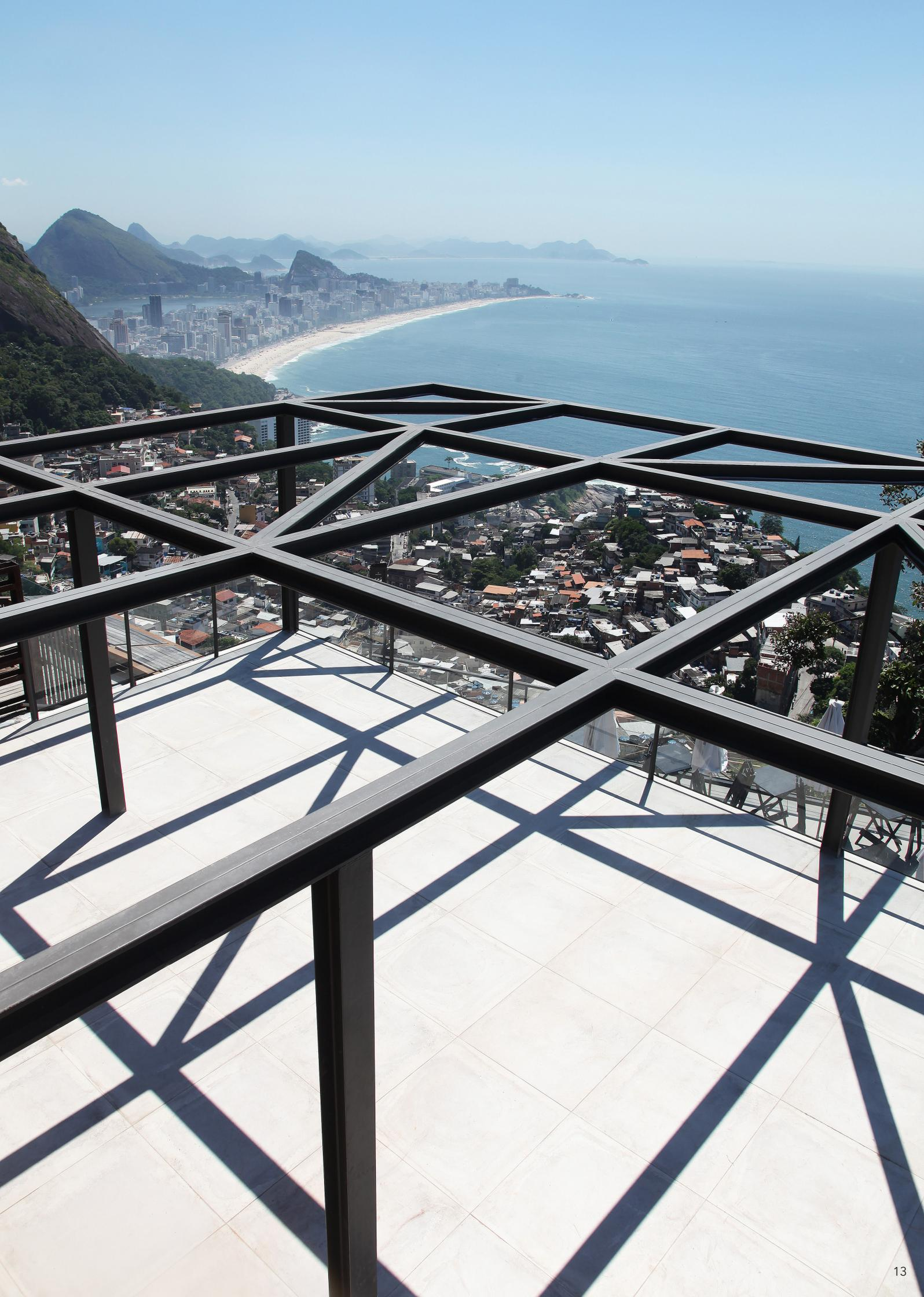
Pour unifier le bâtiment et cadrer le paysage, une pergola en acier recouvre tout l'étage supérieur, en incorporant l'illumination, les supports de plantes, du mobilier et des protections solaires. Cette pergola contraste avec l'impressionnante topographie de Rio, en modulant la structure et en renforçant la relation d'horizontalité entre le bâtiment et le paysage.
